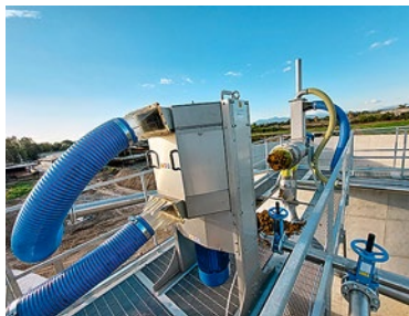
◁ Der Mikrofilter trennt feine Feststoffe aus der Flüssigphase ab.
