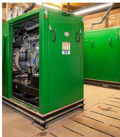
△ Zwei BHKW von 2G mit je 50 kW elektrischer Leistung sorgen für mehr Unabhängigkeit in den Wintermonaten.
