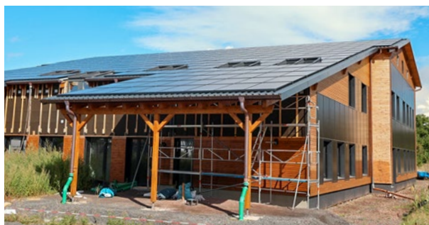
△ Der Solarstrom wird mithilfe von Solaranlagen auf Dach (180 kW) und an der Fassade (69 kW) erzeugt.
