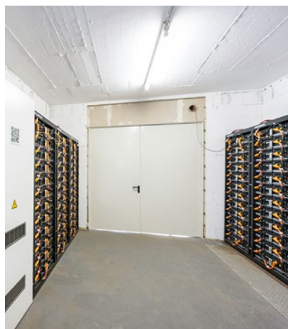
△ Im Batterieraum sind fünf Batteriemodule mit je 98 kWh nutzbarer Kapazität und im Schrank die Wechselrichter untergebracht.
