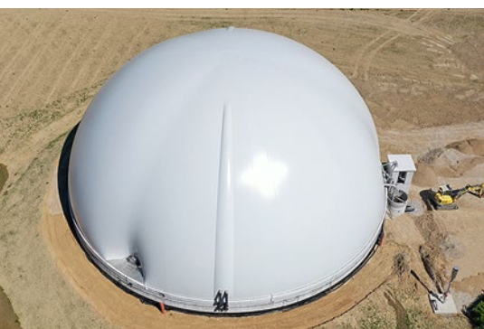
△ Das Speicherdach hat bei gleicher Höhe 13 % mehr Volumen.
