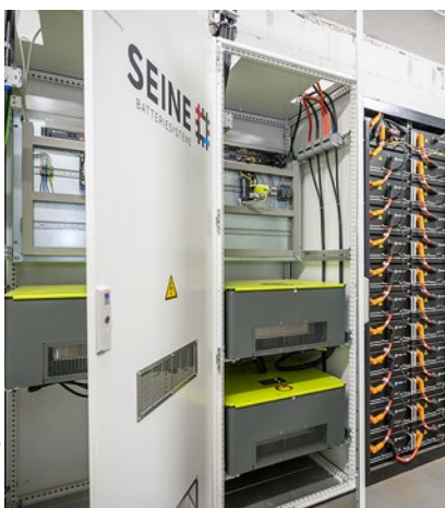
△ Die drei Wechselrichter laden die Batterien mit zusammen 264 kW Ladeleistung.
