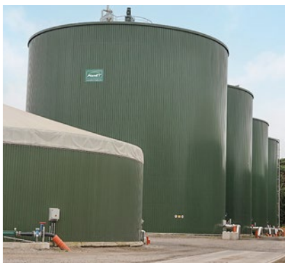
△ Das Material wird in Hochbehältern mit Zentralrührwerk vergoren.
