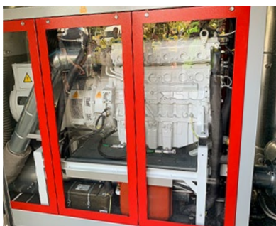
► Ein kleines BHKW liefert Strom und Wärme für das Firmengebäude.
