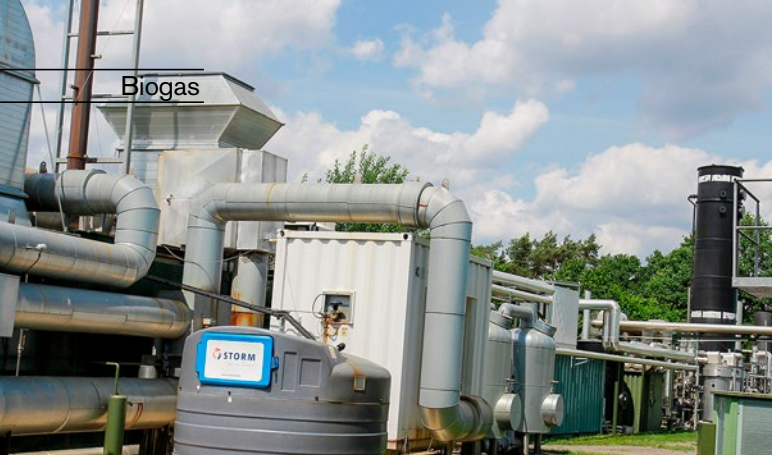
◁ Die Gasaufbereitung nach dem Prinzip der Aminwäsche.
