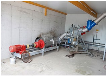
△ Der Energyjet von Vogelsang, eine Kombination aus Feststoff- und Flüssigdosierung.
