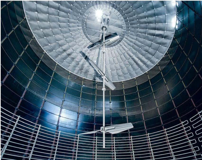
◁ Zentralrührwerke in Hochbehältern sind an der Behälterdecke befestigt (hier ein Modell des Herstellers Suma).
