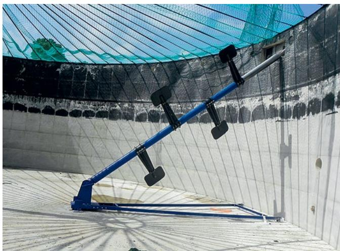
▷ Langachsührwerke werden schräg im Fermenter eingebaut (im Bild das Modell Excentro S von Peters Mixer).
