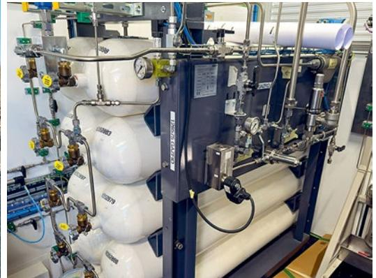
△ Die mobile Aufbereitung ist auf einem Sattelaufleger untergebracht. Das Gas wird komprimiert und in Flaschen gespeichert (rechts).
