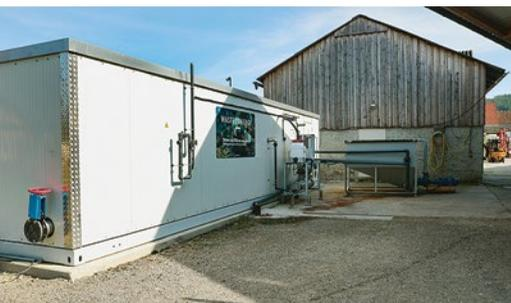
◁ Die Mikrobiogasanlage ist in einem 40-Fuß-Container untergebracht.
