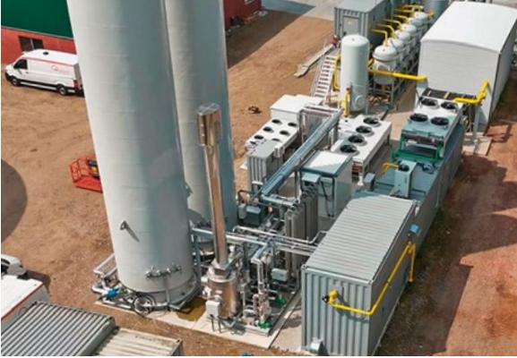
◀ Blick auf eine Gasaufbereitung von ETW mit CO<sub>2</sub>-Verflüssigung: Die Techniken ergänzen sich laut Hersteller gut.
